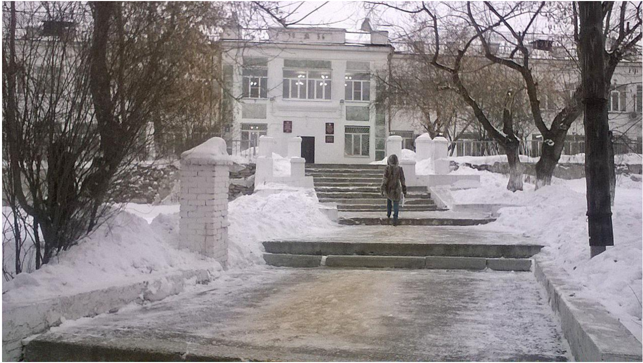
Центральная лестница, ведущая к зданию
